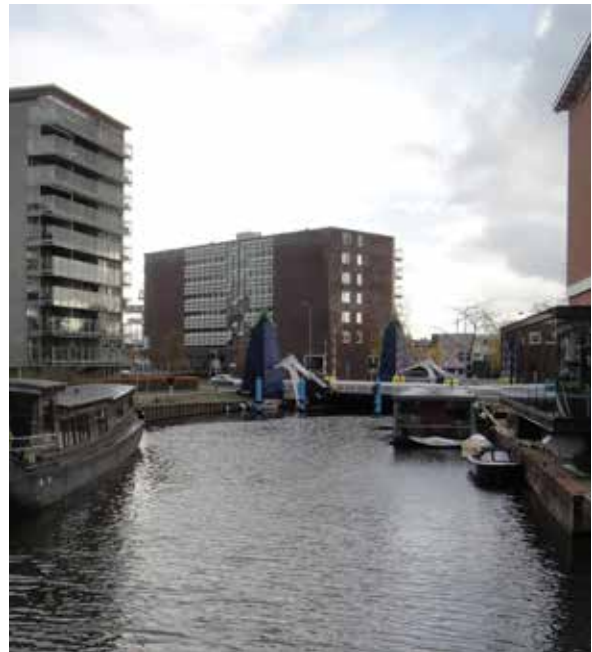
Huidige situatie bij de Bontebrug. Rechts op de foto een stukje van de graansilo.
