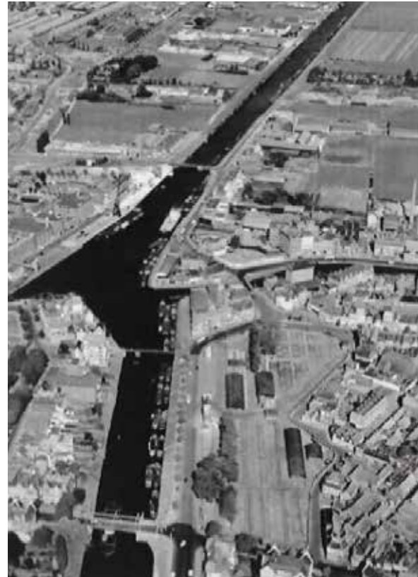
Fig. 5 Het Verbindingskanaal (onder) en Eemskanaal (boven) omstreeks 1955. Bron: Gemeente Groningen (2014) Cultuurhistorische Verkenning binnenstad Groningen stad.
